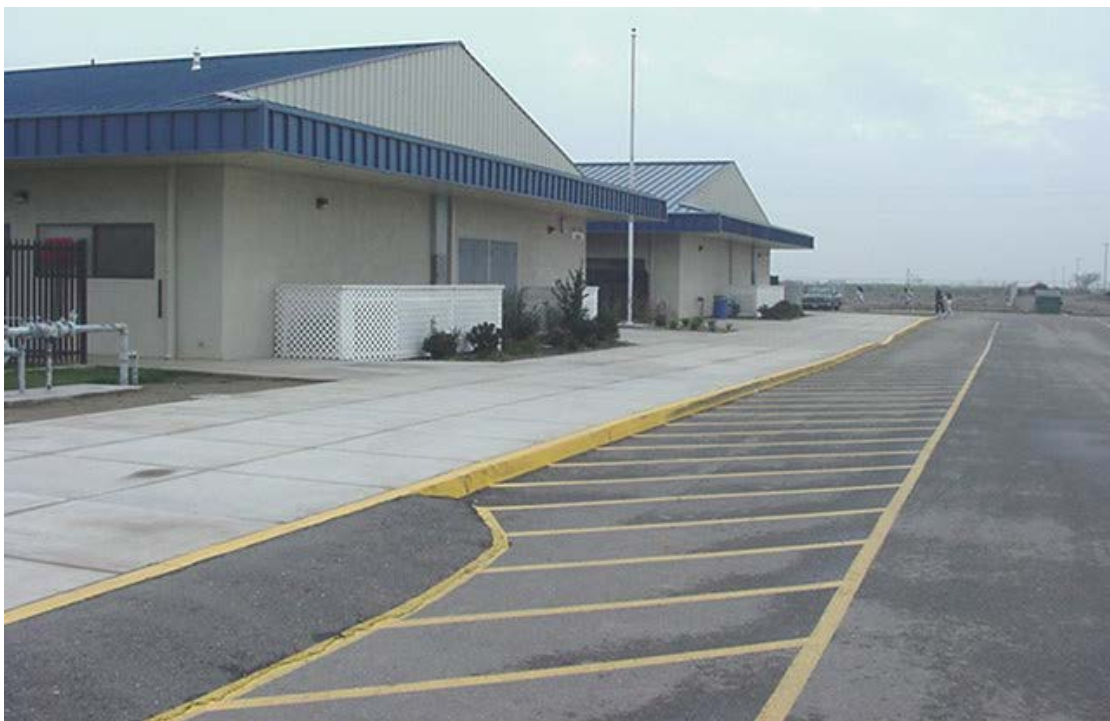
Esta foto ilustra bien marcada las varianzas de acera y estacionamiento con pintura amarilla. Tomando las precauciones tales como éstas, se reducen considerablemente las posibilidades de resbalones y caídas.
