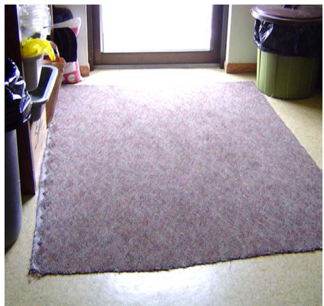
Esta foto muestra un mal ejemplo de un tapete para piso. Restos de alfombra no deben utilizarse en estas áreas. No están diseñados para retener agua y suciedad, no son antideslizantes y se enrollarán y en los bordes se deshilacharán.
