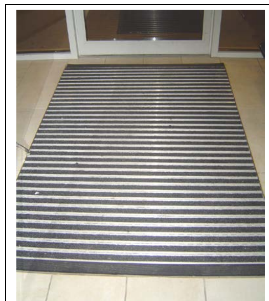
Esta foto muestra un excelente control para reducir al mínimo el potencial de resbalón y caída en las entradas. Es un sistema de rejilla con un sumidero, se construye en la superficie del piso. Si esto no se puede instalar, utilicé alfombras de piso o corredores.
